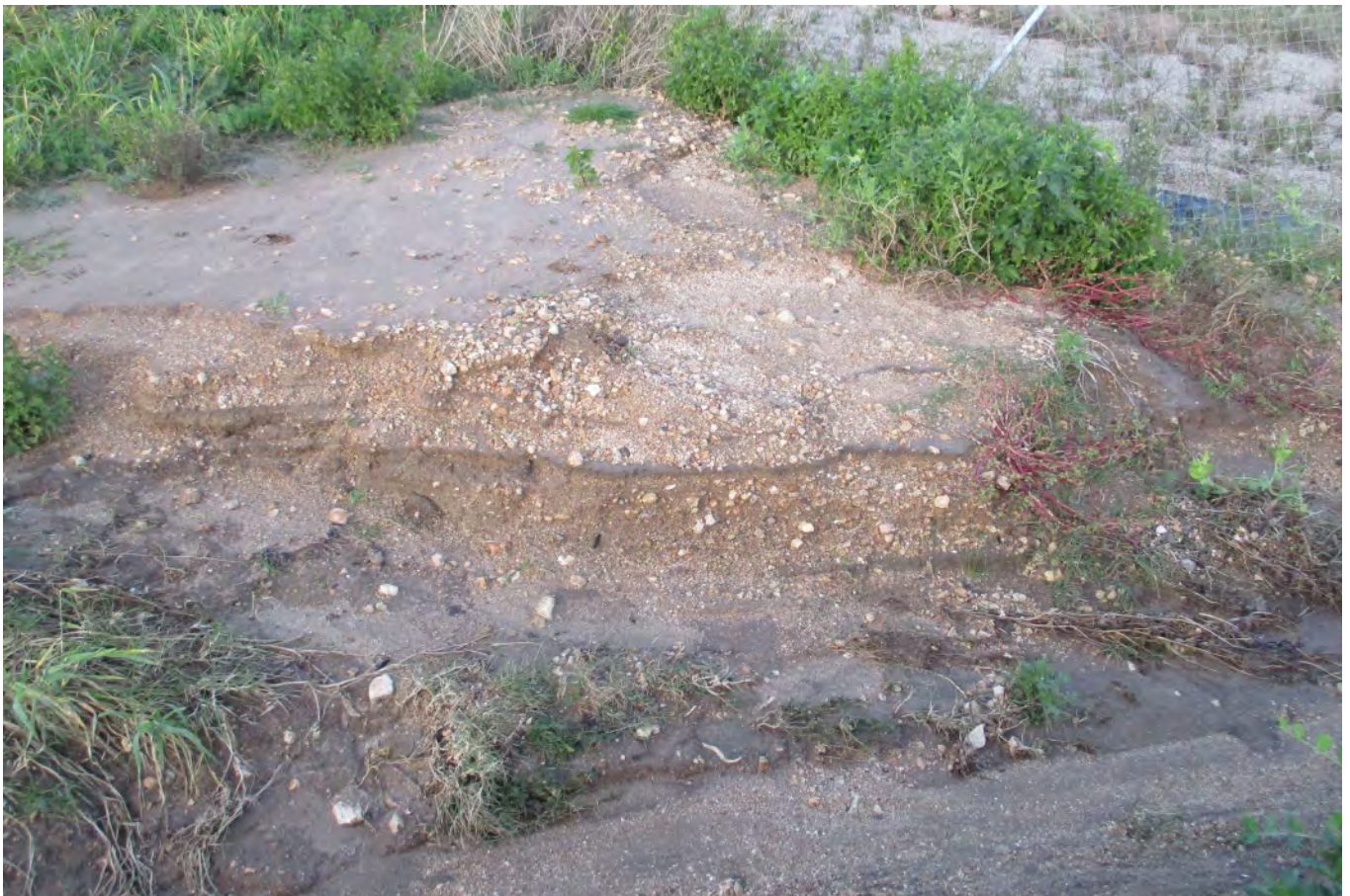
Tav. III - CABRAS - Mont'e Prama. 1-2: il fossatello scavato dalle acque correnti e l'accumulo di ghiaia e argille depositato all'esterno della recinzione dopo le piogge dell'agosto 2018 (foto A. Usai)
